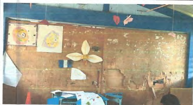
Foto 3: Sustitución y mejoramiento de divisor de aulas.
