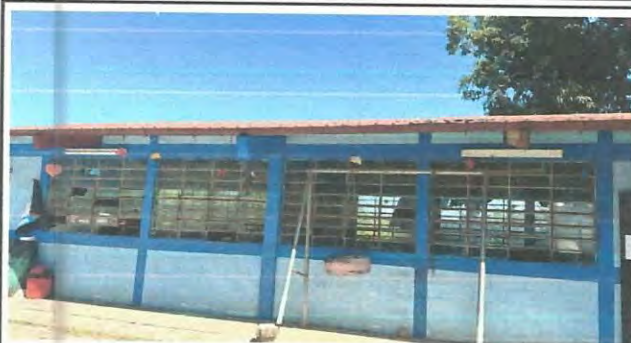
Foto1: Mejoramiento de ventanas y balcones del edificio escolar parte interior.
