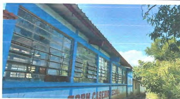
Foto 2: Mejoramiento de ventana y balcones del edificio escolar parte exterior.
